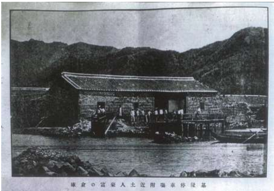
圖 六-3 基隆火車站旁倉庫
