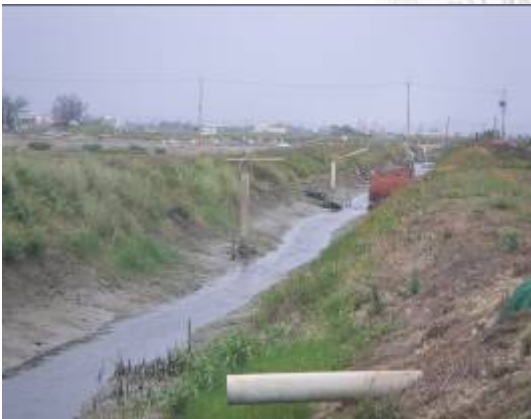
圖 3-33 試驗區排水路中露出排水管
