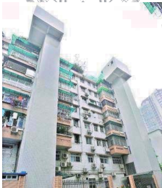
圖 1-2 舊樓加裝電梯[4]
