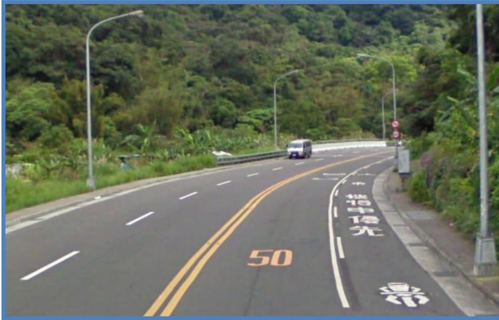
圖 2.2.2 快、慢車道之間無實體分隔路型布設示意圖
