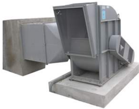
圖 3-34 單吸翼截式風機【本研究整理】
