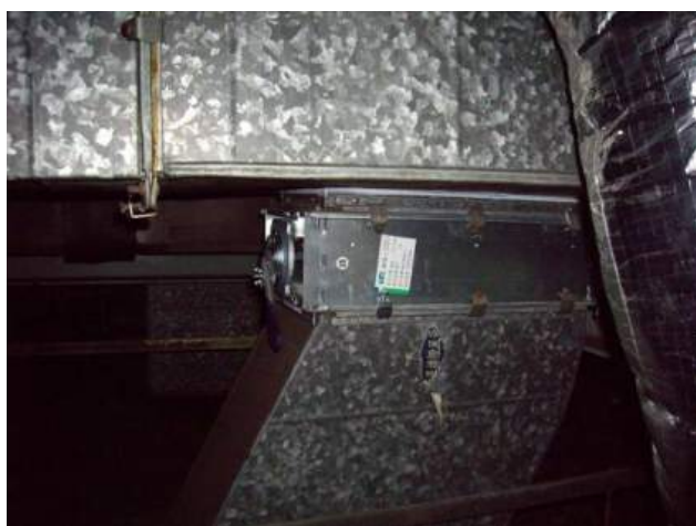
圖 3-47 改善中風管銜接煙罩設置風量開關 V.D
