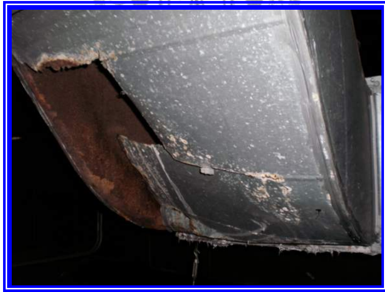
圖 3-33 風管腐蝕【本研究整理】
