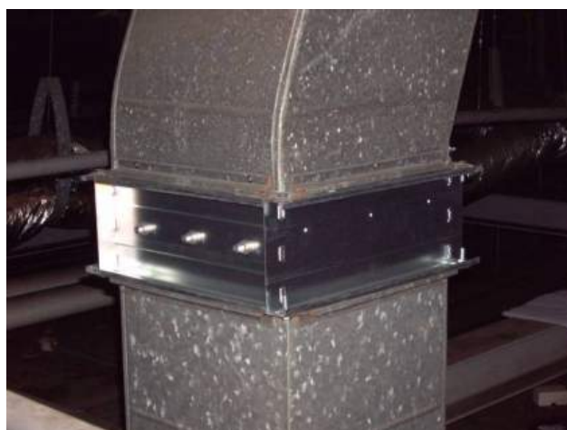
圖 3-47 改善中風管銜接煙罩設置風量開關 V.D
