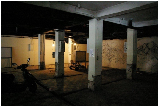
圖 6 南機場二期地下室改造前照片 圖片來源：有種，南機場 FB 粉絲專頁 (2016)
