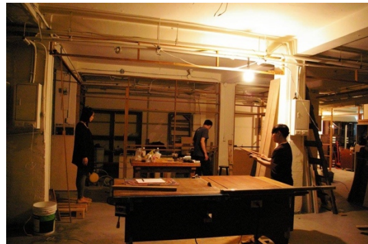
圖 7 南機場二期地下室改造過程照片 圖片來源：有種，南機場 FB 粉絲專頁 (2016)
