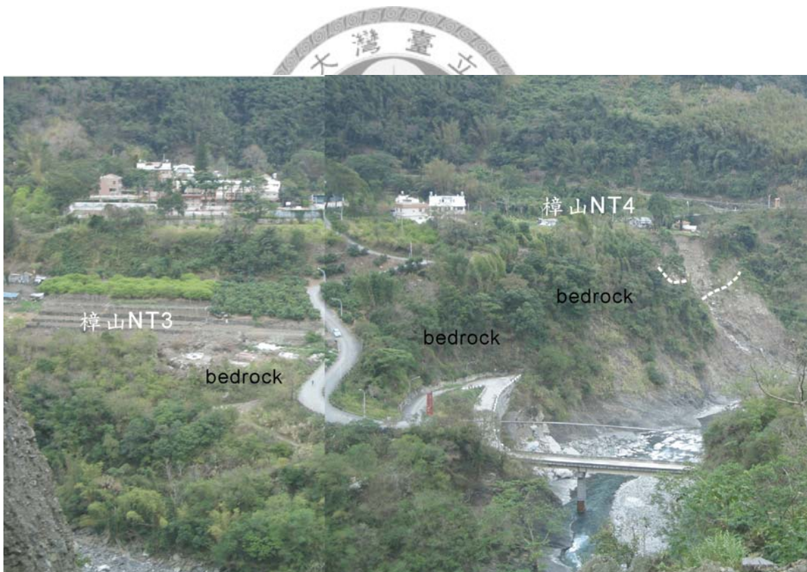
圖 3-4 樟山 NT4 及 NT3 遠照圖。白色虛線為基岩出露位置，樟山 NT4 南邊出露約厚 25~30 公尺厚之沈積物，底下岩盤出露高約 40m，露頭型態似為古河道。
