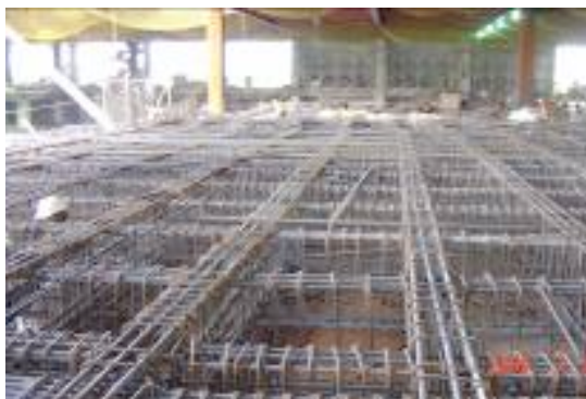
(a) 格子版鋼筋綁紮
