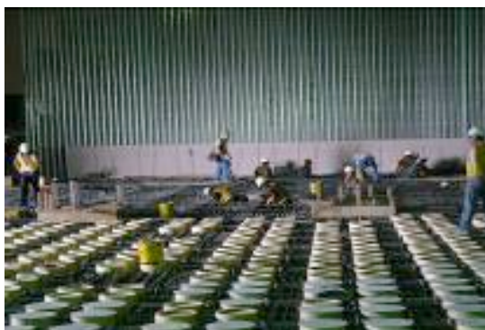
(c) 灌漿前檢查並安裝FRP頂板
