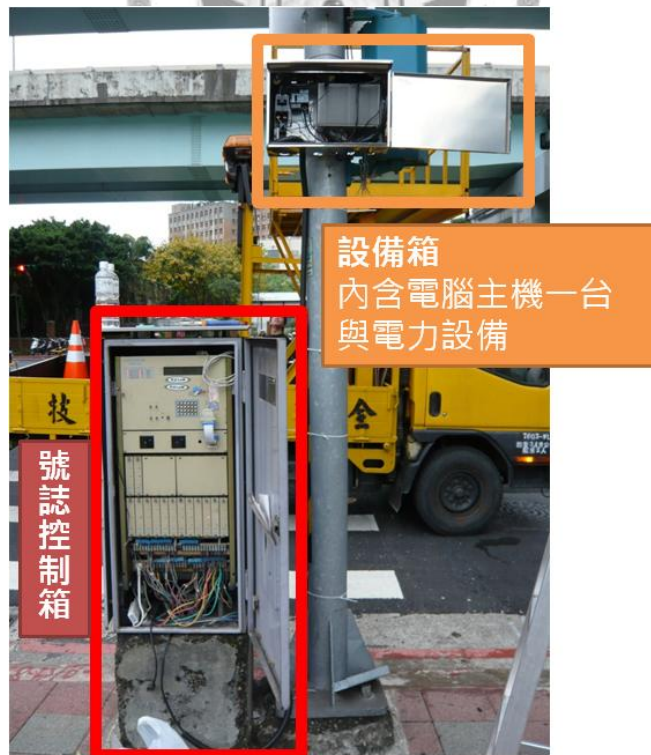
圖 3.5 現場設備裝設情況
