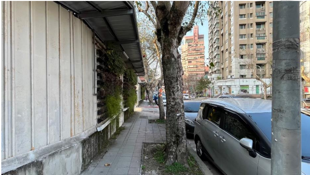
圖 63 綠圍籬灌溉水溢流導致止水墩與人行道青苔化
