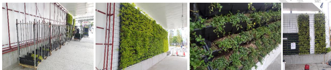
圖 43 專利型綠圍籬施工照片
