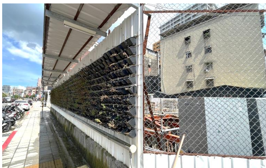
圖 35 工地圍籬安全通道（走廊）照片
