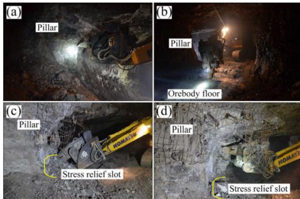
圖 2.11 不同開挖狀態(a)無應力解壓槽狀況下(b)礦底開挖(c)開挖應力解壓槽(d)有應力解壓槽狀況下(摘取自 Wang(2022)等)
