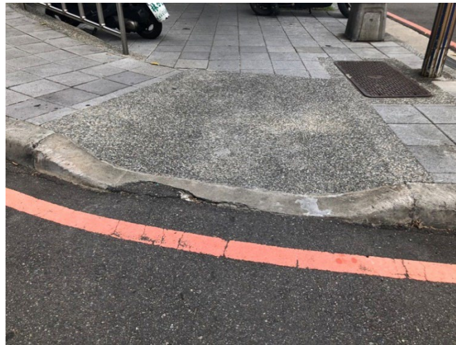
附圖 2-1 無障礙設施中提及之路緣斜坡（馬路及人行道交界之斜坡）
