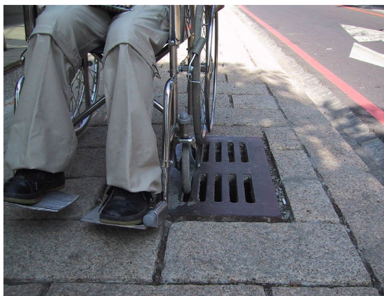
圖 2-12 排水溝孔洞水平於人形方向
