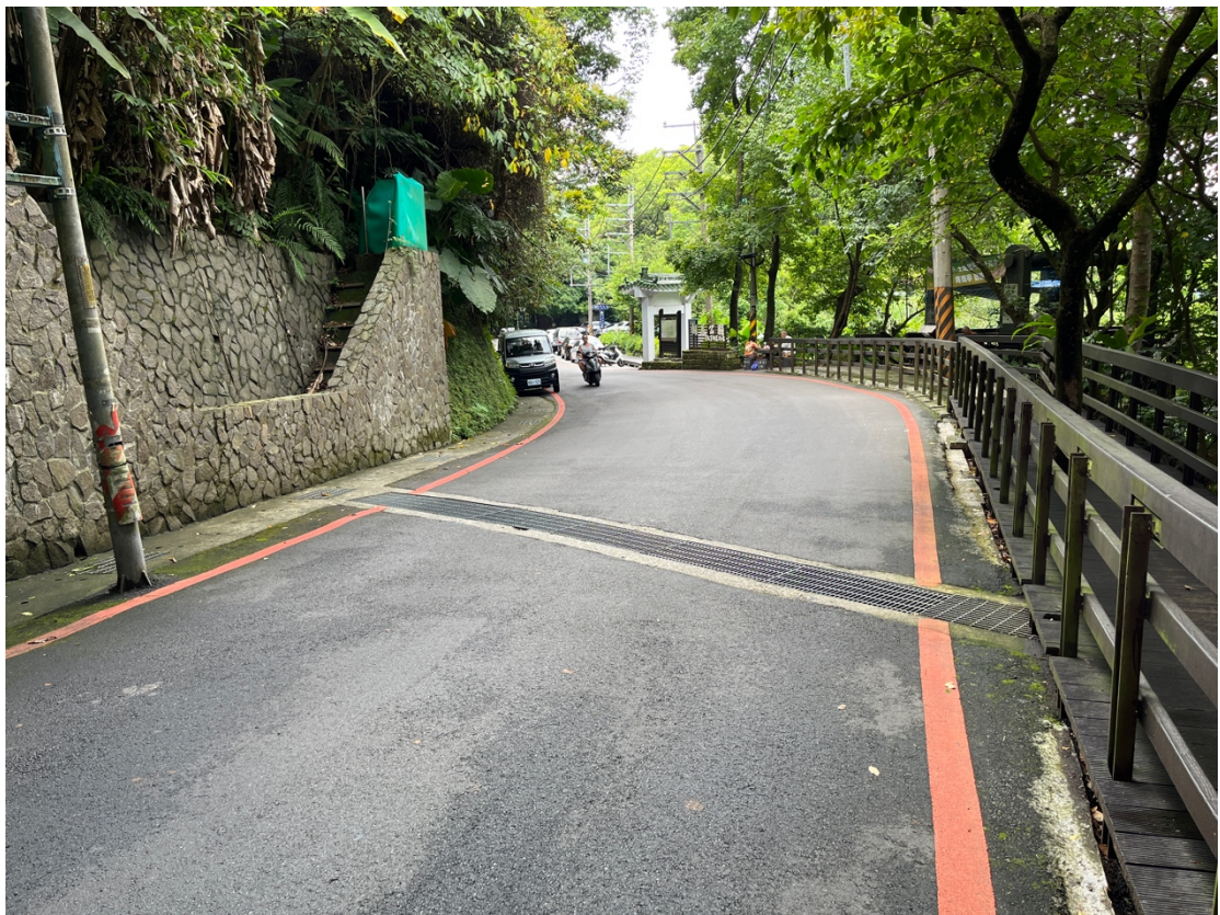
圖 49、工程改善後，非網狀誘導設施引導生物通過截水溝穿越道路
