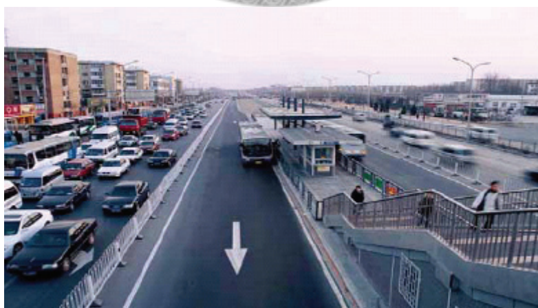
圖 3.2-36 北京南中軸 BRT 之封閉性
