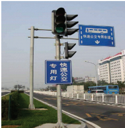
圖 3.2-45 BRT 專用號誌 資料來源：劉璇亦(2007)
