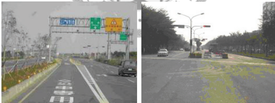
圖 2.5-3 嘉義 BRT 公車捷運專用車道設置狀況
