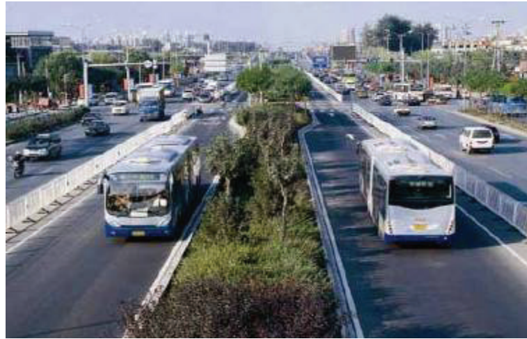
圖 3.2-39 永定門-三營門公車專用車道
