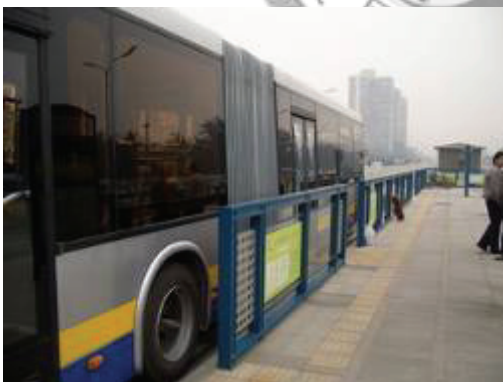
圖 3.2-32 站台防護設施
