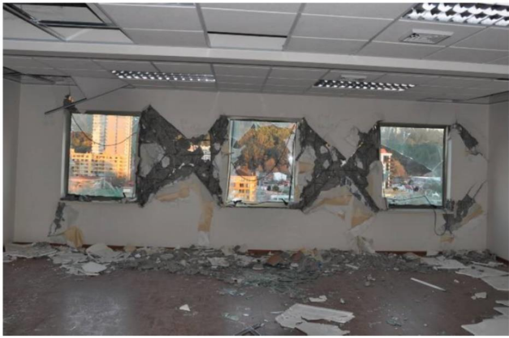
圖 1-2 RC 牆大量開窗造成明顯剪力破壞
