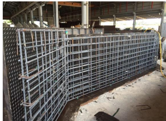
圖 68 預鑄樓梯結構配筋照片 (資料來源:參 18)
