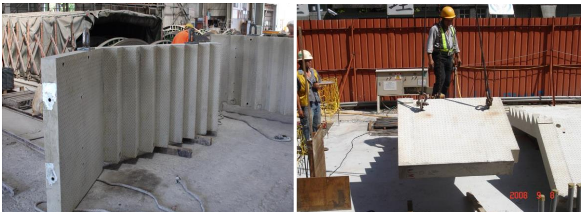
圖 49 接合部及吊掛點照片(資料來源:參 17)
