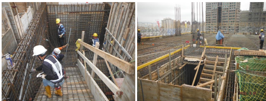
圖 106 場鑄樓梯模板組立照片
