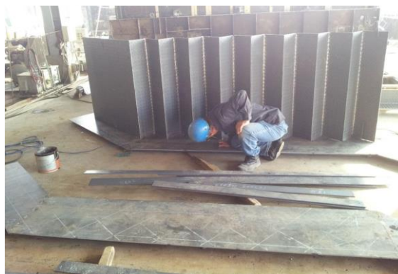
預鑄樓梯鋼模尺寸檢查
