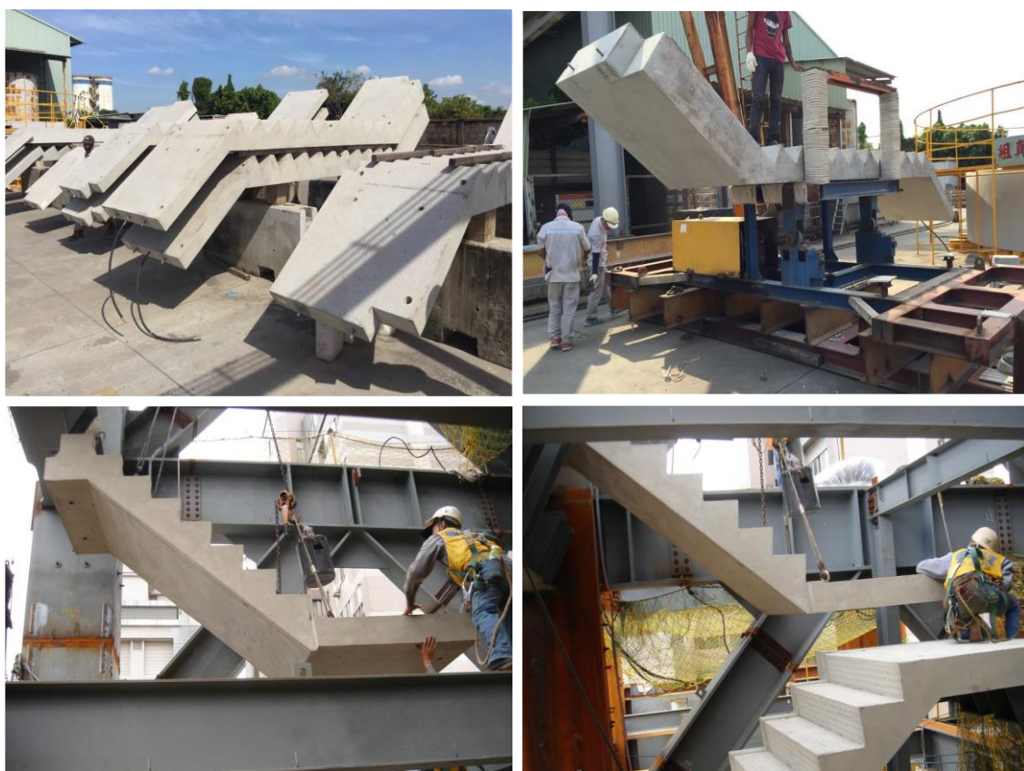
圖 111 預鑄樓梯版片及吊裝照片(資料來源:參 17、參 18)
