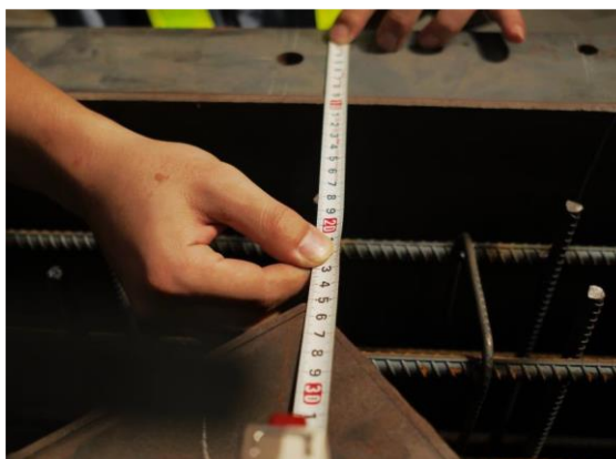
圖 75 鋼模尺寸檢查 (資料來源:參 17)
