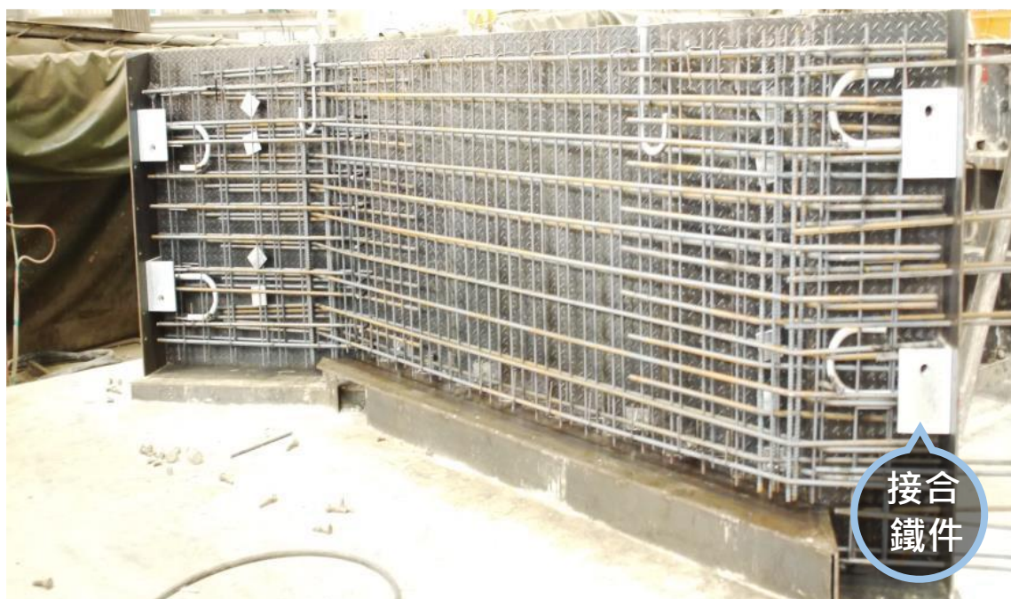
圖 57 預鑄樓梯接合部鐵件照片(資料來源:參 17)
