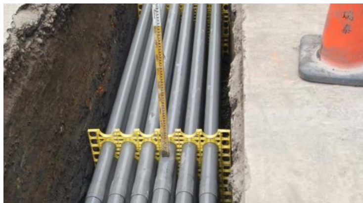
圖 2.8 電信管線埋設 (中華電信台北營運處，2010)
