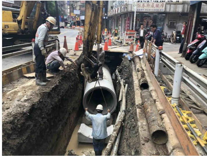
圖 2.11 鋼筋混凝土管埋設 (新北市水利局，2021)
