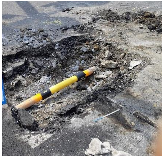
圖 2.12 瓦斯管線修復處理 (臺北市政府工務局，2018)
