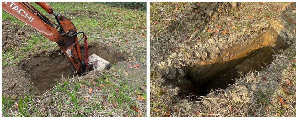
Figure 3.66: 怪手開挖試坑
