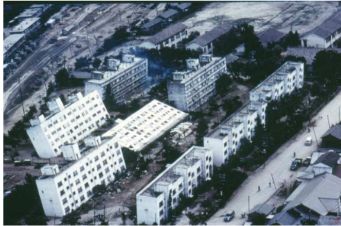
Figure 2.2: 1964 年日本新潟縣因土壤液化造成建物傾倒 (Bird et al., 2005)
