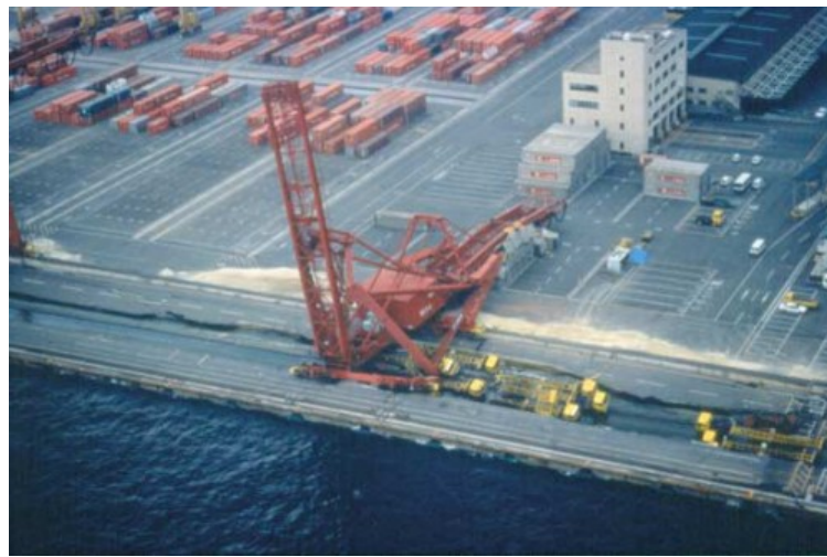
Figure 2.4: 1995 年阪神大地震造成神戶港港灣設施嚴重受損 (Bird et al., 2005)
