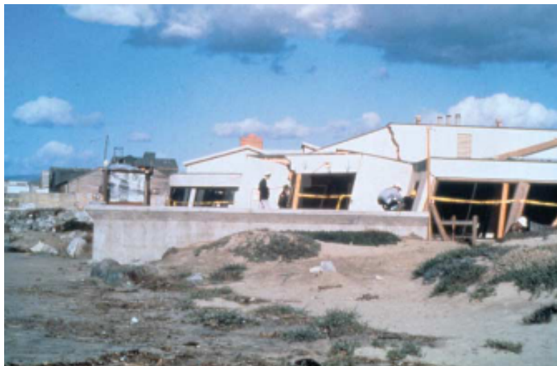
Figure 2.11: 1989 年美國洛馬普里塔地震造成側潰破壞 (Bird et al., 2005)
