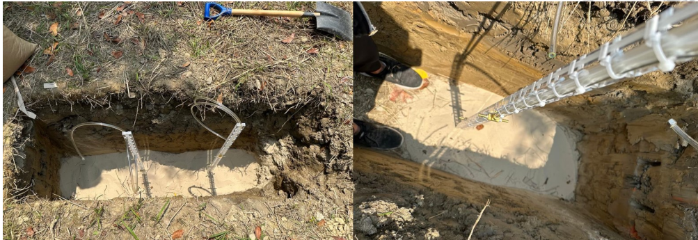
Figure 3.67: 放置澆灌管線輔助壓克力基座
