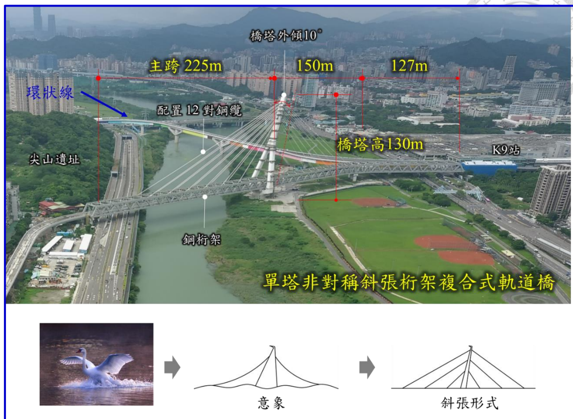
圖 4-2 安心橋配置及造型發想示意圖(整理自新亞建設企劃書，2016[43])
