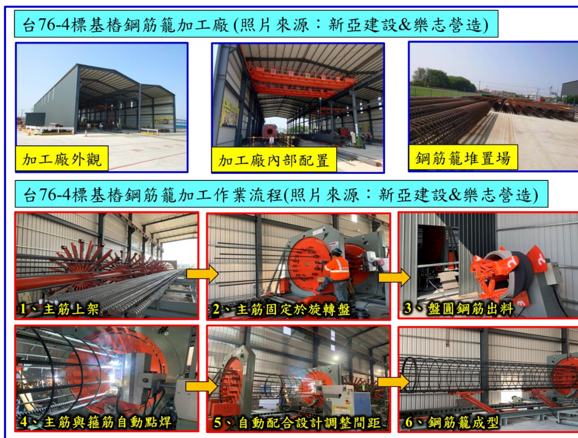
圖 5-9 台 76-4 標基樁鋼筋籠加工廠配置及加工作業流程(新亞建設，2023[52])
