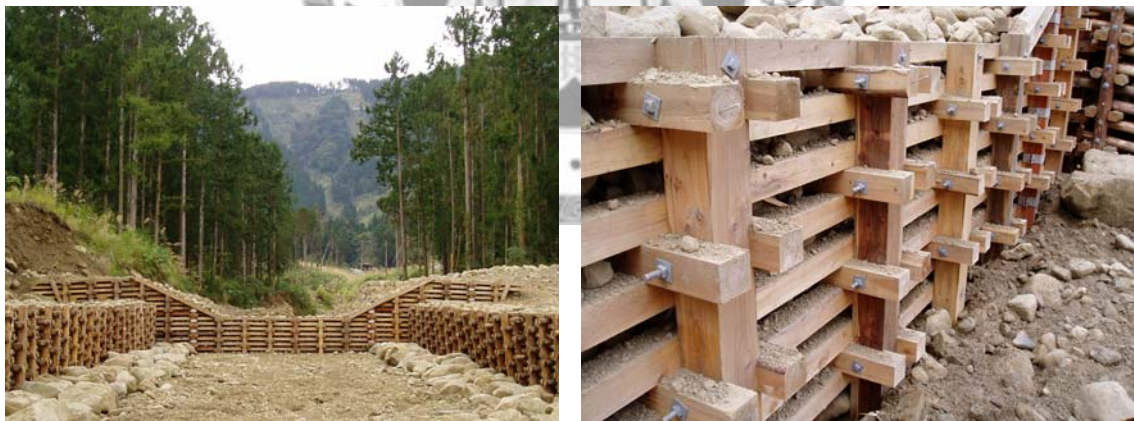
圖 15. 使用新工法所製作之節制壩
