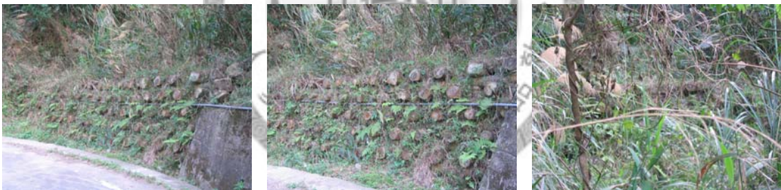
圖 A.7 工程 I，共 2 座木格框擋土牆，路旁 1 座，草叢裡另有 1 座（右圖）
