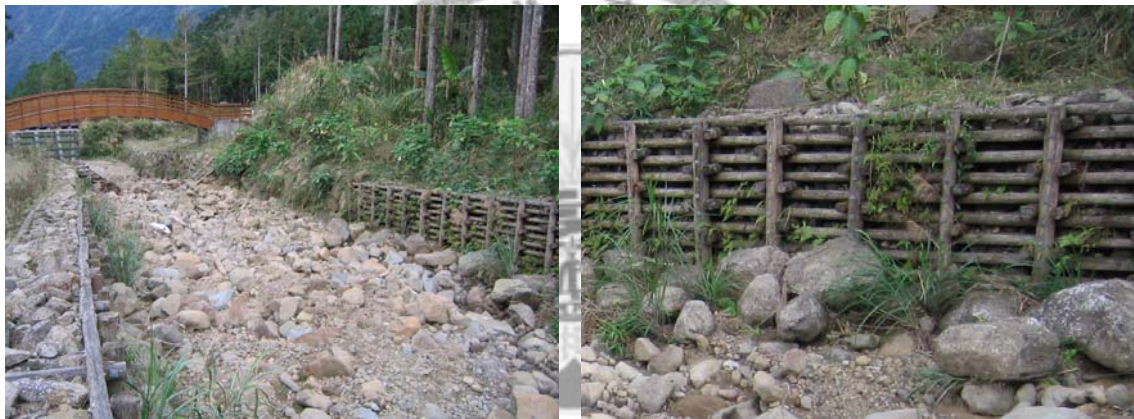
圖 16. 大學坑木質河岸護坡及近拍照
