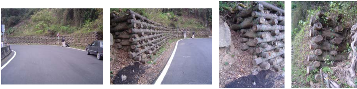
圖 A.9 工程 K，在台 16 線彎道上，植生較少較乾燥。 右 2 圖分別為擋土牆的左右兩端
