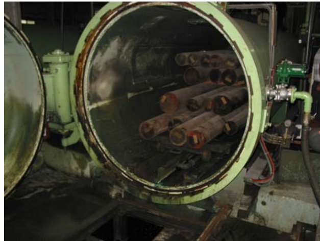
圖 11. 柳杉防腐處理狀況
