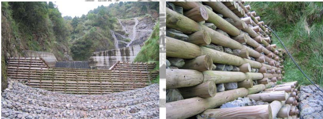
圖 13. O&D 工法製作之節制壩及近拍照
