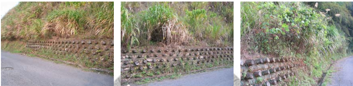
圖 A.6 工程 H，擋土牆上方的禾本科植物生長十分茂密
