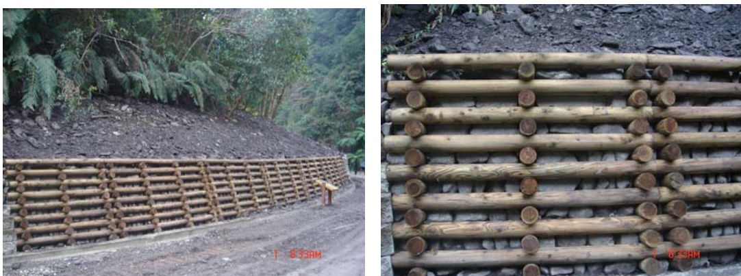
圖 14. O&D 工法製作之擋土牆及近拍狀況
