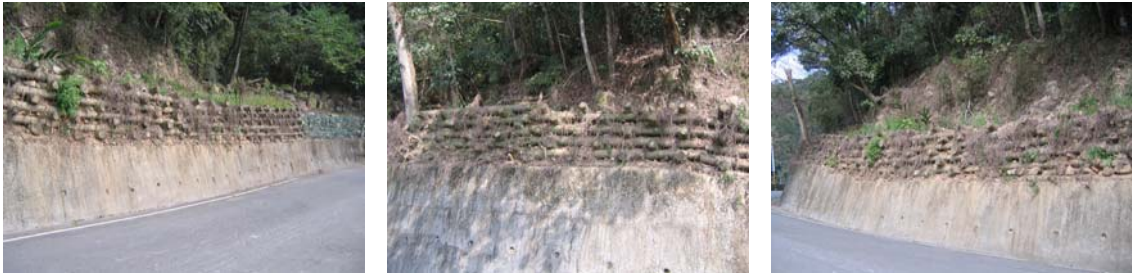
圖 A.5 工程 G，可看出當地環境較乾燥，由左圖可見旁邊建有蛇籠
