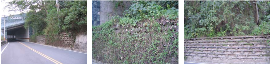
圖 A.16 工程 R。位於民和明隧道後。
