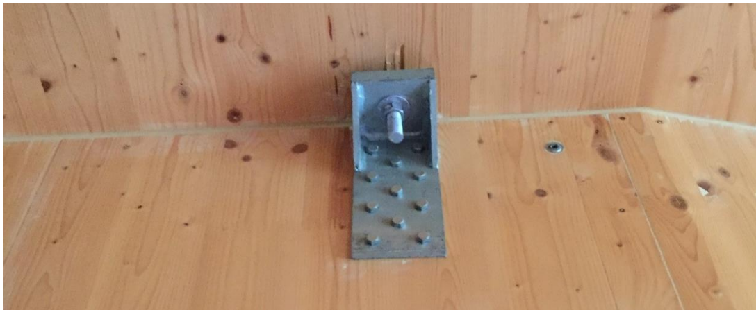
圖 3- 4 木構造 CLT 建築樓板與牆板結合處 本研究拍攝
