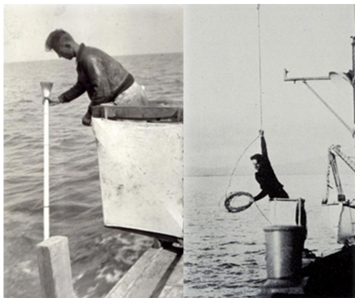
圖2.10 測深桿與測深錘現地操作(UCAR)
