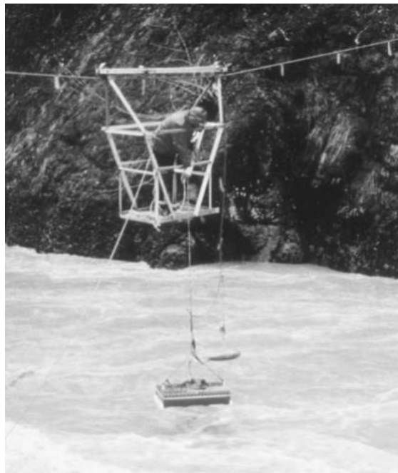
圖2.12 以鋼索懸掛 GPR 進行現地量測(Spicer et al., 1997)
