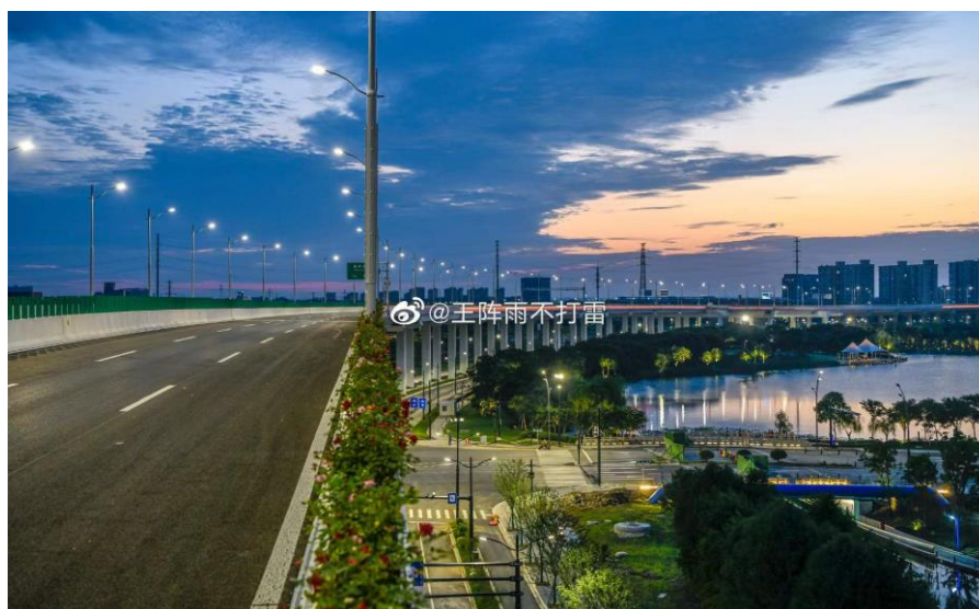
圖 2-8 姚家蕩公園的高架快速道路
