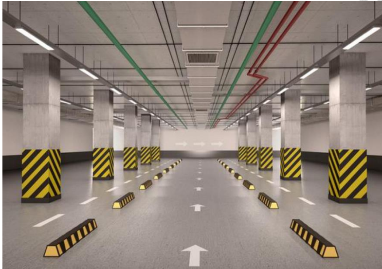
圖 1.1 平版結構系統(flat plate floor system)示意圖
