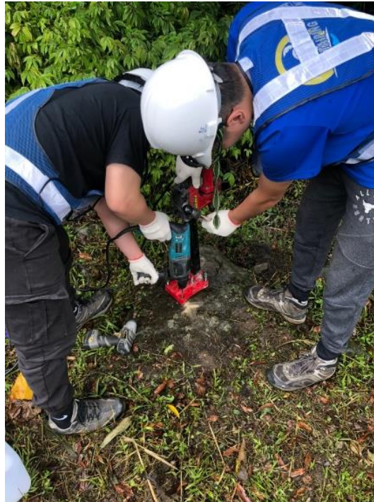
圖 2-2-2、架設岩心鑽機。使用電鑽在岩石表面鑽取洞孔，洞孔內放入壁虎內迫(固定用)，將鑽機機座的固定孔對準洞孔，讓鑽機牢牢固定在岩石上。
