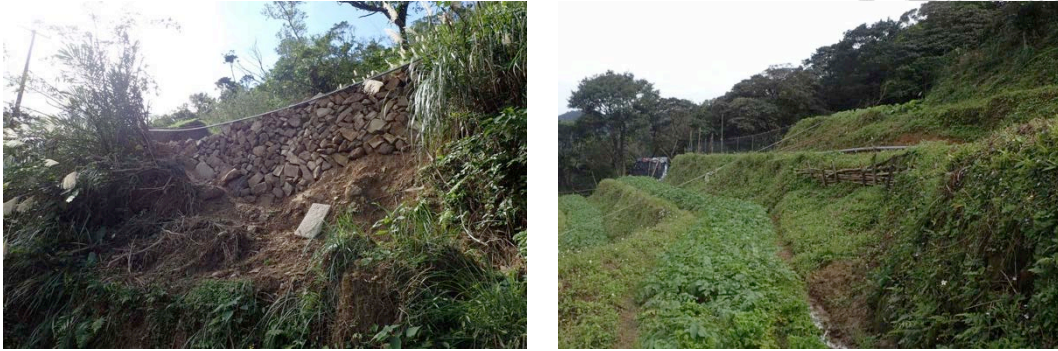
Fig. 2-3 對於崩塌田埂的維修方式
