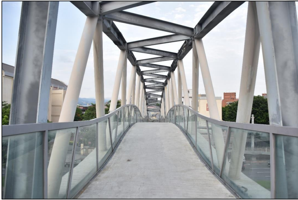
圖 2- 19 位於葫蘆國小旁的跨堤天橋
