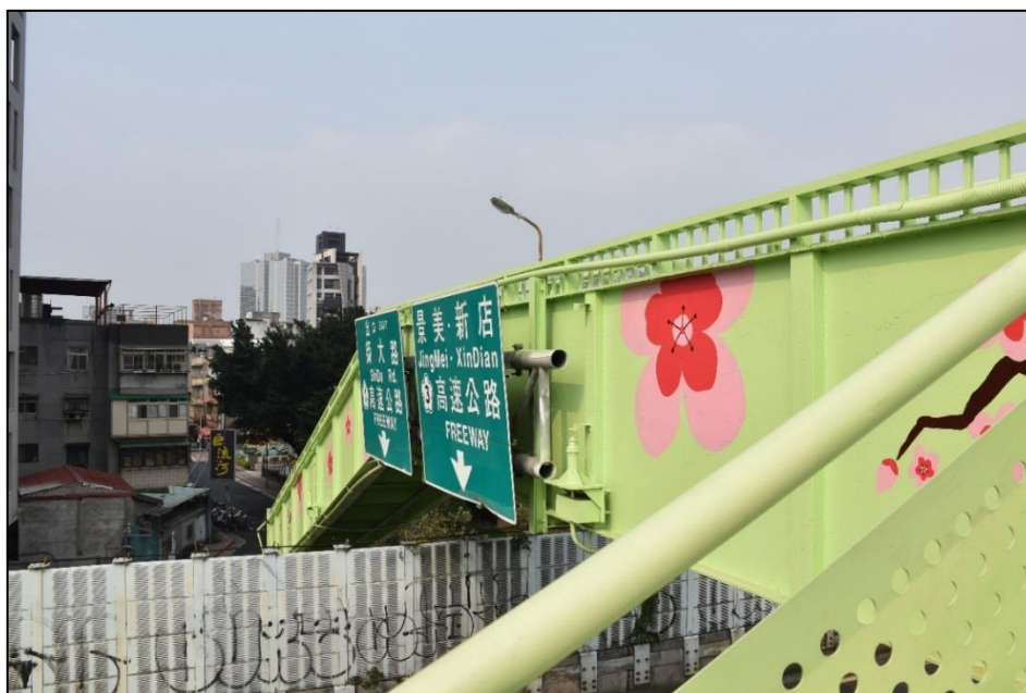
圖 2-15 位於同安街口的跨堤天橋
