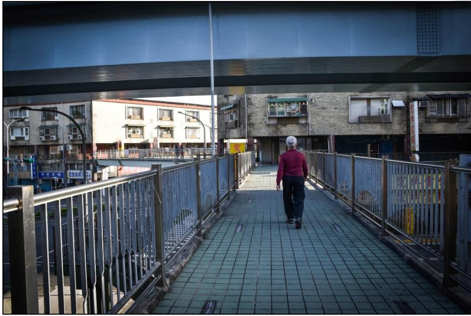
圖 3- 13 連結棟與棟之間的跨道路天橋
