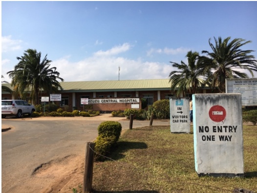
(照片 1) Mzuzu Central Hospital 大門
