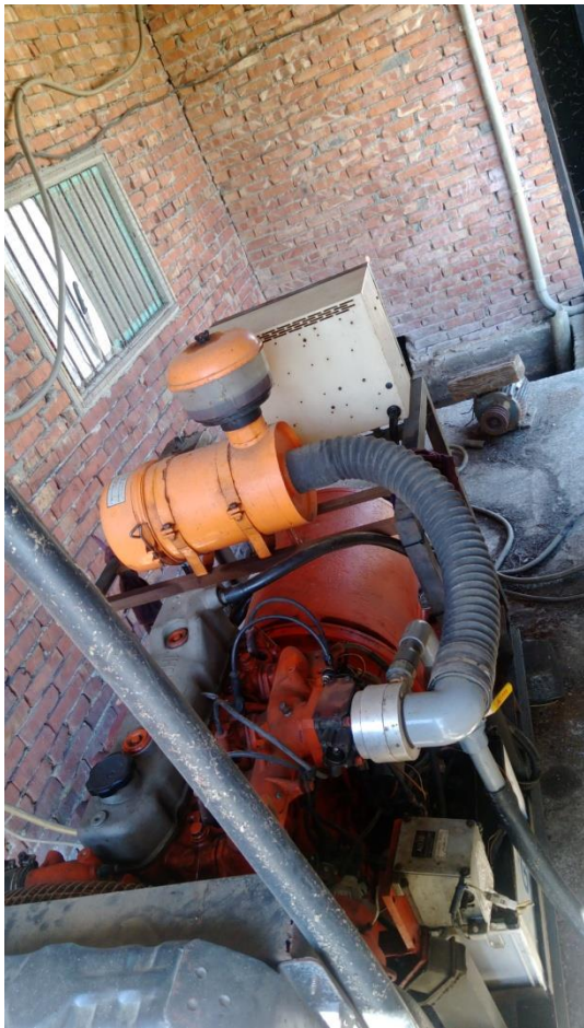
圖 3-2-17 日製淘汰柴油卡車引擎改裝發電機及自製水脫硫塔
