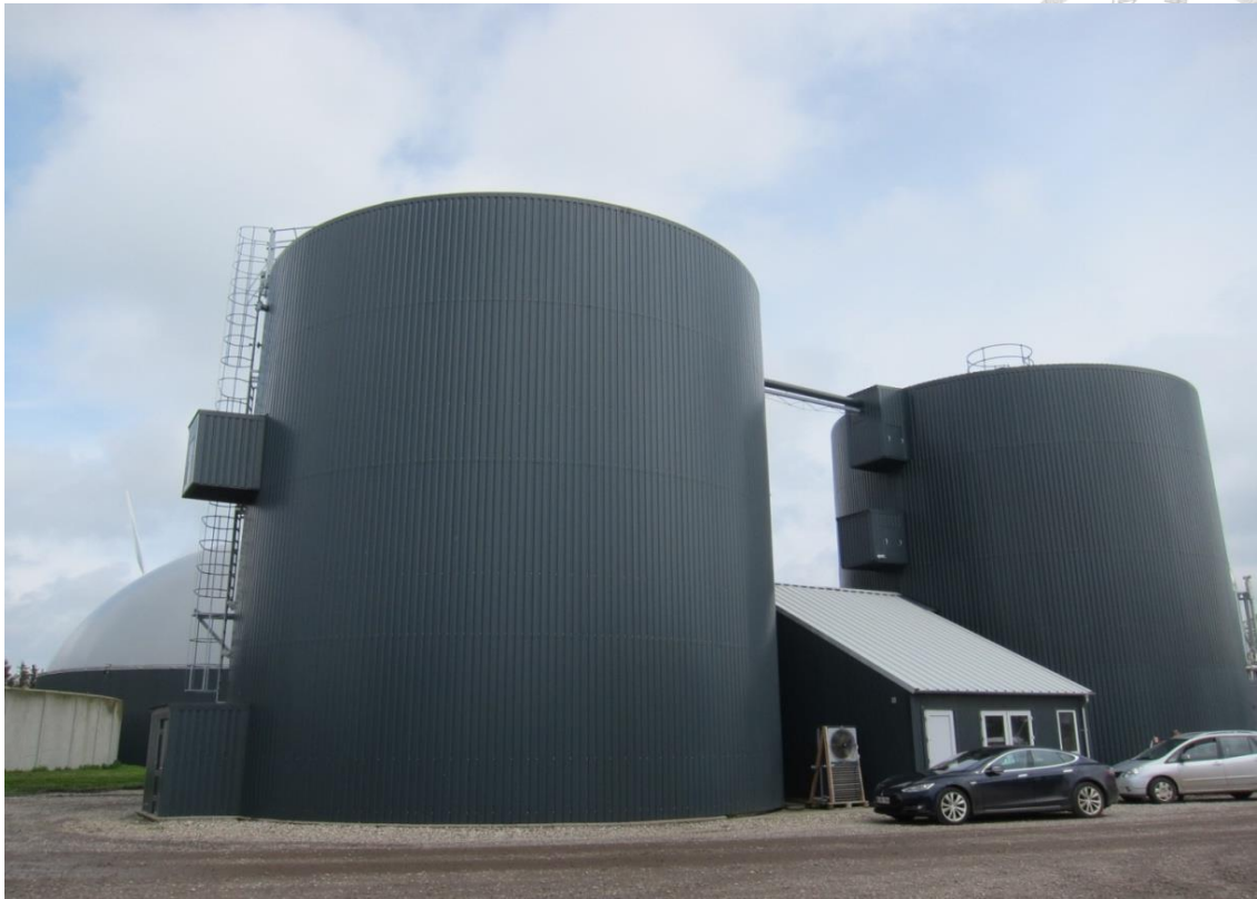
圖 3-3-3 丹麥沼氣廠之厭氧發酵槽、共發酵調勻槽、儲氣槽
