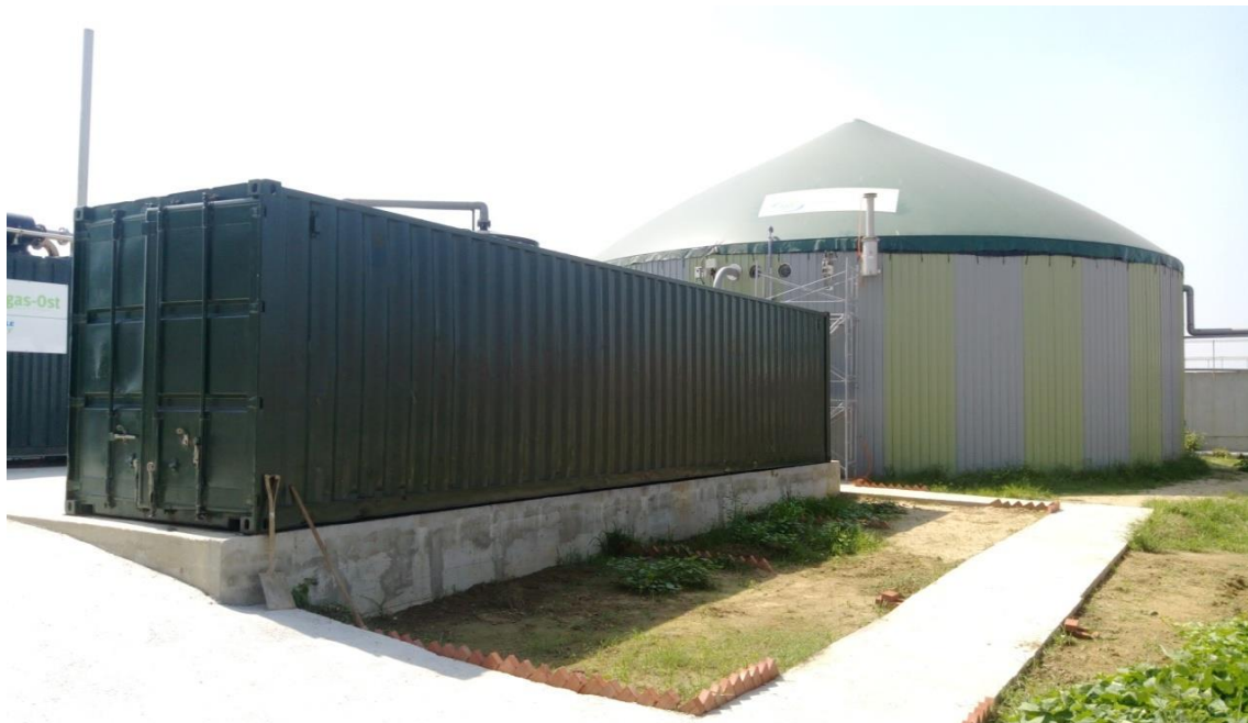
圖 3-3-2 德國技術直立攪拌圓桶厭氧發酵槽及貨櫃內置發電機
