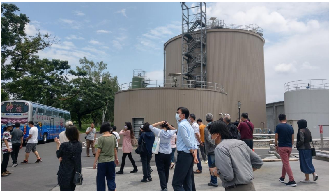
圖 3-2-19 歐規 USTR 全攪拌直立圓筒厭氧發酵槽，調勻槽，厭氧發酵槽
