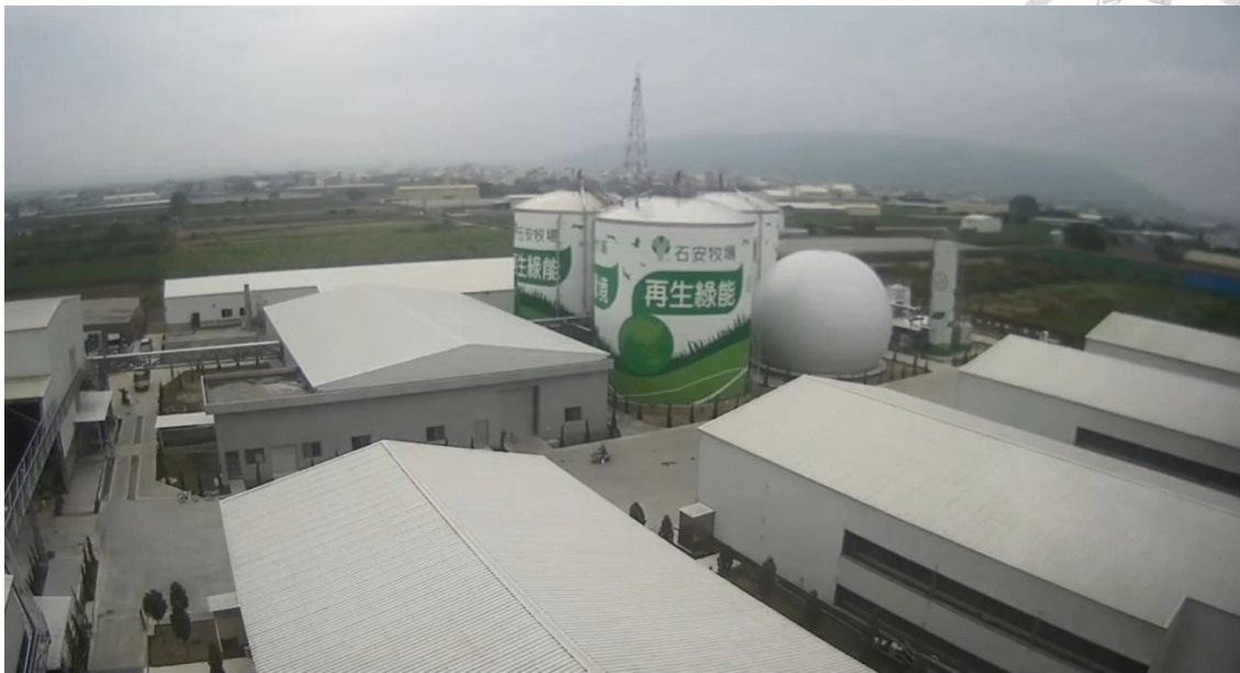
圖 3-3-5 高雄市石安蛋雞場之丹麥裔中製厭氧發酵槽、調勻槽、儲氣槽
