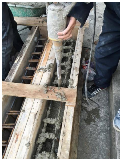
照片 4-3 振動棒振動搗實
