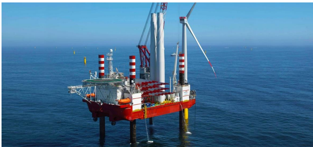
圖 2-9 風機安裝照片
