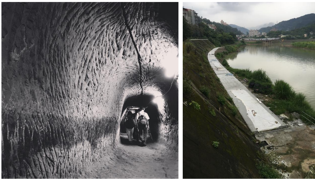
圖 35 大坪林引水石腔，以及「碧潭堰上游至烏來沿線亮點營造第一期工程」
