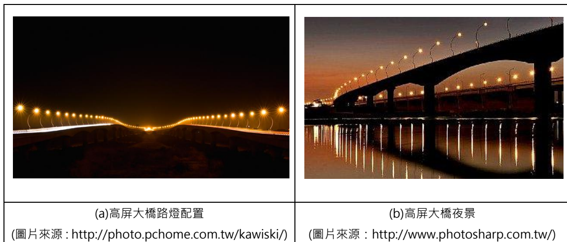
圖4-7 高屏大橋夜間照明現況
