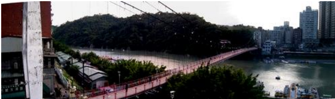
圖3-11 碧潭吊橋全貌(圖片來源： http://www.worldatlaspedia.com/ ，下載於 2011 年)
