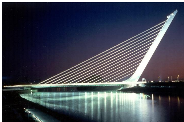
圖2-14 西班牙的 Alamillo Bridge(圖片來源： http://travelguide.bloguez.com/ ，下載於 2011 年)
