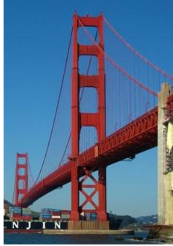
圖3-10 舊金山金門大橋索塔造型(圖片來源： http://justinsomnia.org/ ，下載於 2011 年)
