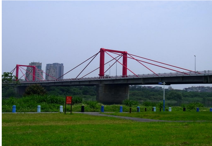
圖3-21 光復橋全貌(圖片來源：本研究拍攝)
