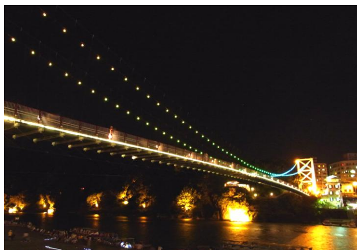
圖3-15 碧潭吊橋照明設計整體表現(圖片來源：本研究拍攝)
