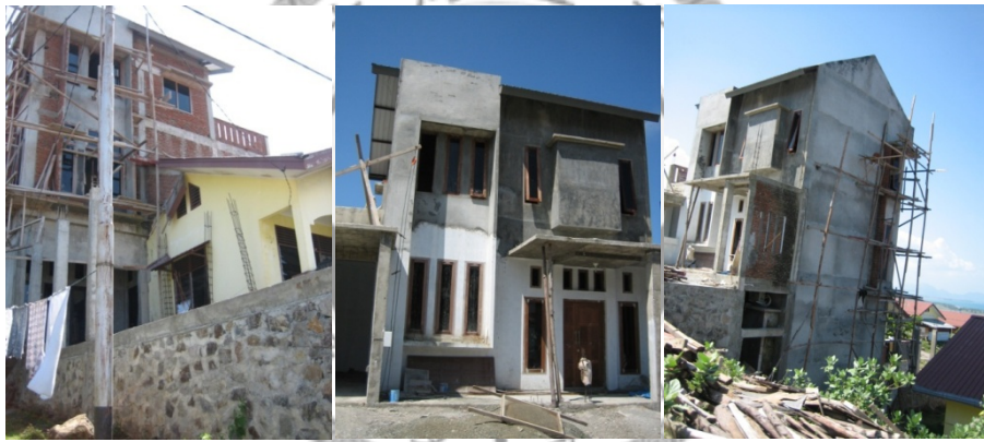
圖 5-9：加蓋 3 層樓的房屋外觀
