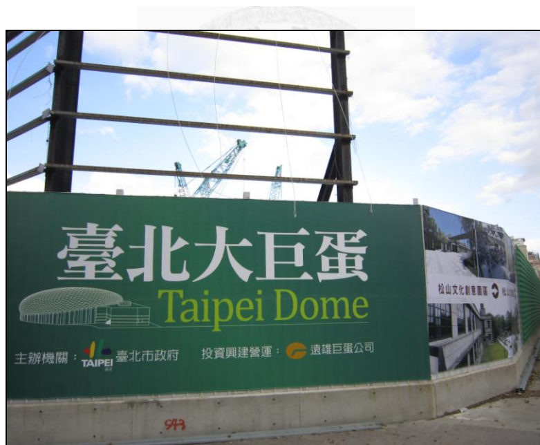
圖 3-3 大巨蛋場館施工現況
