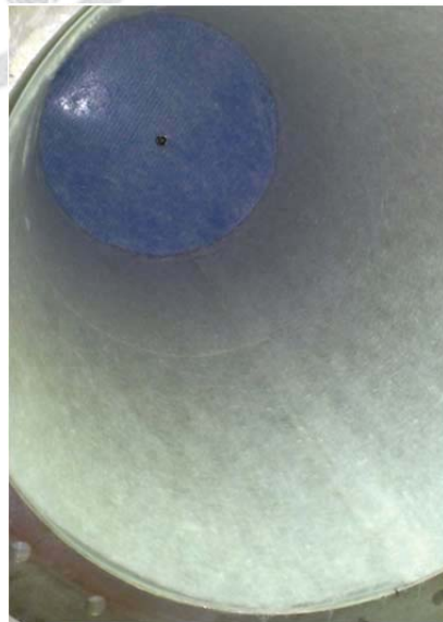
壁面貼附材料設置完成。
