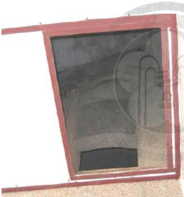
(圖4-58)玉清宮二樓迴廊天花板內的仿木混凝土構造 61
