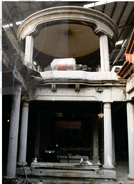
(圖 3-23.2)宗聖公祠左中過水廊鋼筋混凝土結構空間。
