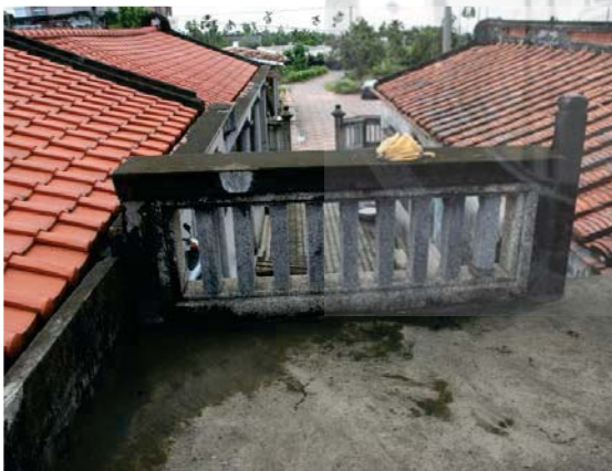
（圖 3-40）崁頂港東村羅宅過水廊頂平台（筆者自攝，2012.08）
