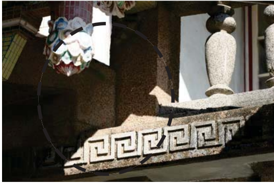
(圖4-66)從現在拜亭下方還可依晰看出二樓明間前迴廊往本堂明間露臺的連接通道。(筆者自攝，2012.12) (圖4-67)從明間迴廊前方可見通往露臺的連接通道。 64
