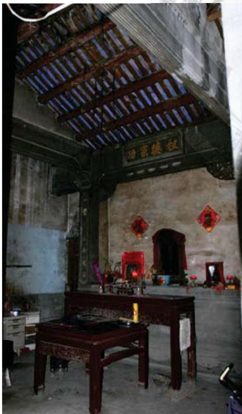
(圖 3-18) 右堂簡略的神龕，沒有龍柱，以木雕作為樑柱交接處的雀替(筆者自攝，2008.8)
