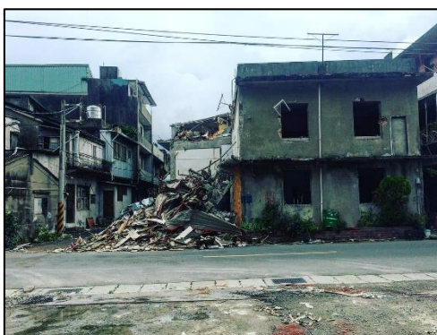
圖 47 宜興雜貨店全棟拆除
