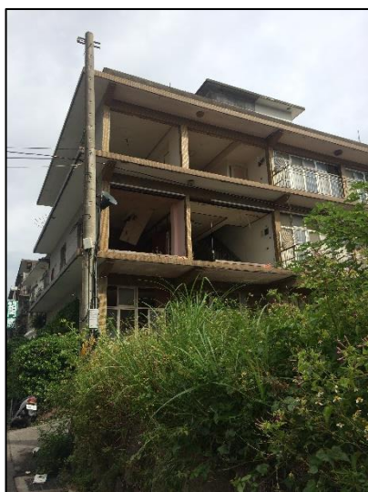
圖 45 門窗、欄杆拆除後的連棟透天
