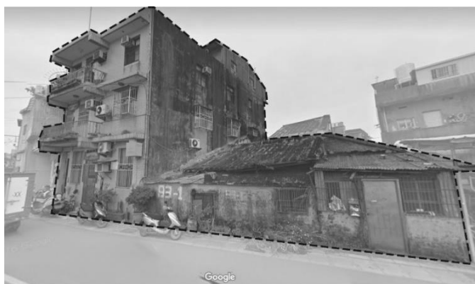
圖 33 拆除部分磚造房屋改建透天
