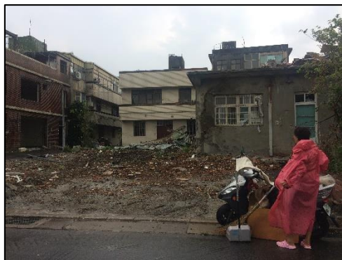
圖 46 屋前休憩的鐵棚拆後照片
