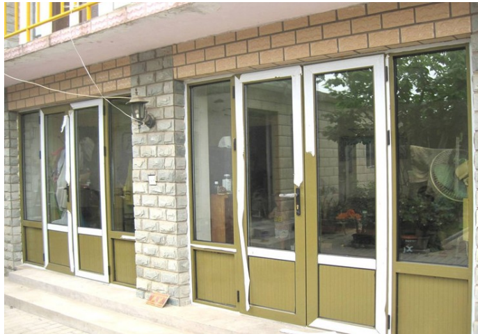
圖 五十：斷橋鋁改造後的實景
