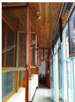
圖 四十三：改造工程接近完工時，可見已將廊道保溫封頂完成；室內牆體也重新整修去潮。
