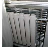
改造后：贴了暖气板反射片，使得暖气能更高效率运作。
