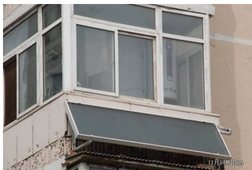
圖 二十五：安裝在自家樓層外側的壁掛式太陽能熱水器，段允東先生屬於「凡事
