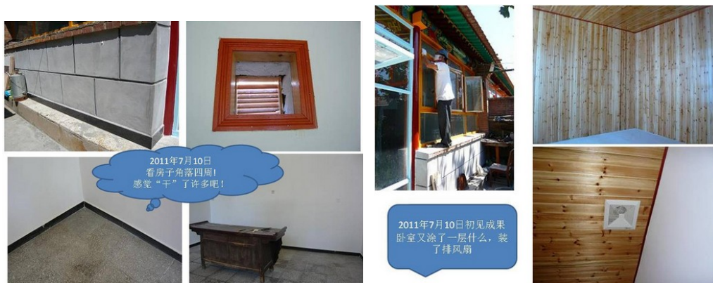
圖 四十五：通風裝置與保溫牆的完成。在室內裝上內牆內保溫及塗上護油。
