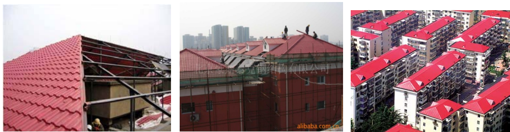
圖 三十八：平改坡目的在於改善樓宇冬冷夏熱及漏水的狀況。二來也因為北京奧運期間為了城市美觀，那時也有大量的平改坡工程進行。圖片來源：
