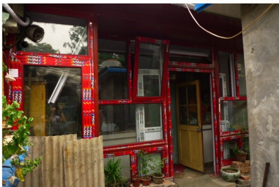
圖 三十六：家住平房區的杜香泗自行改造完工的隔熱保溫廊道正面
