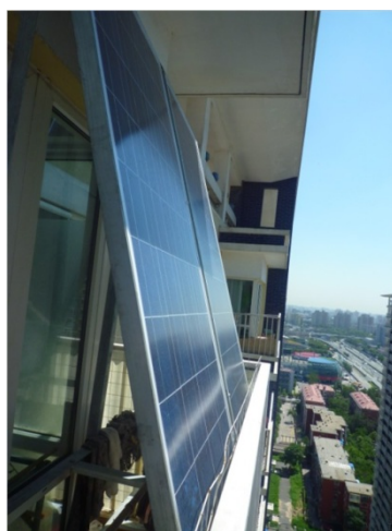
圖 五十五：裝設在 26 層樓陽台的太陽能光電板（陳婉寧攝）
