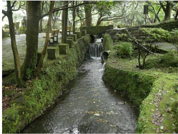
圖 4-4-7 自 B 區流出之溝渠
