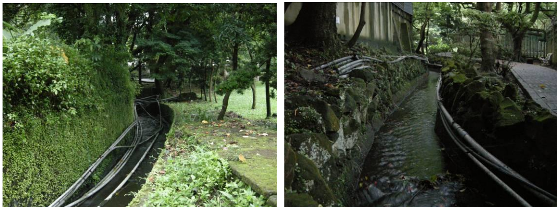
圖 4-4-4 入口處之溝渠
