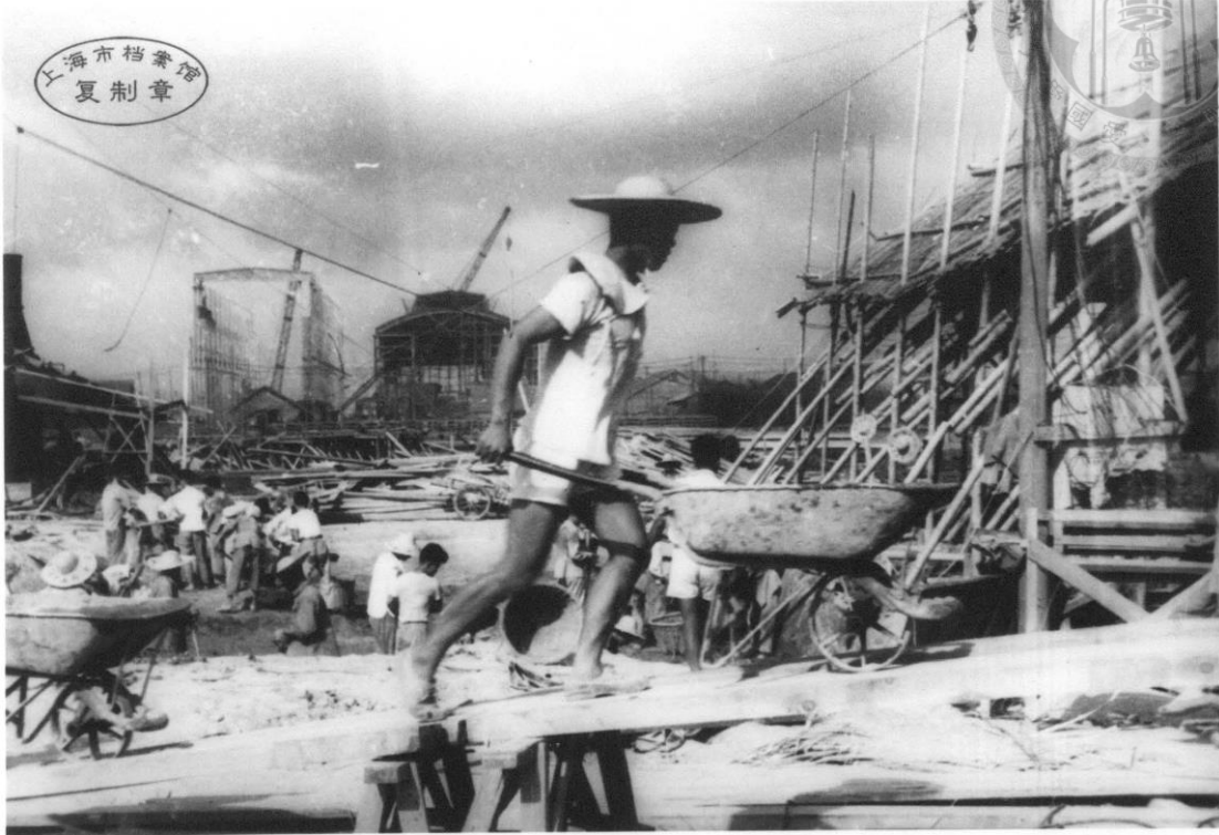
圖 16 學生參與建築工地生產勞動 288
