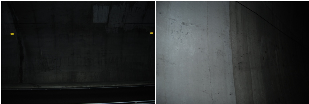
圖 2.6 隧道內部現場實際影像
