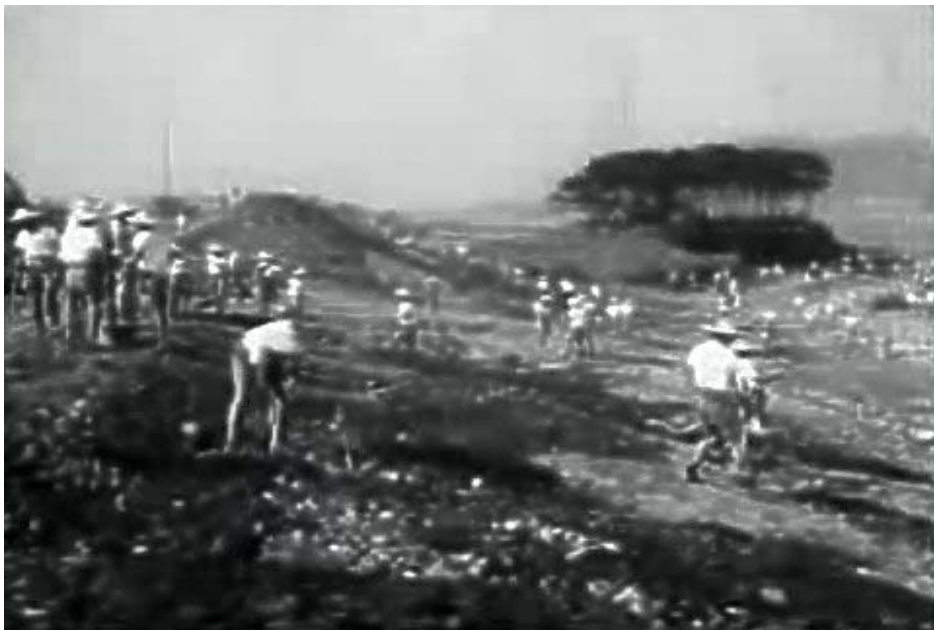
圖 15 永和鎮 1962 年堤防修築過程。
