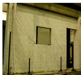
(g) 中間垂直牆段因支承固定度不佳，使裂縫超過臨界斷面[4]
