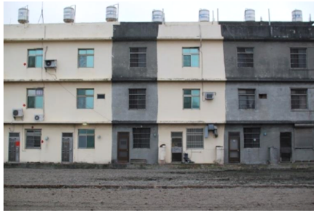
圖 2-17 實際既有街屋屋後牆開口[4]
