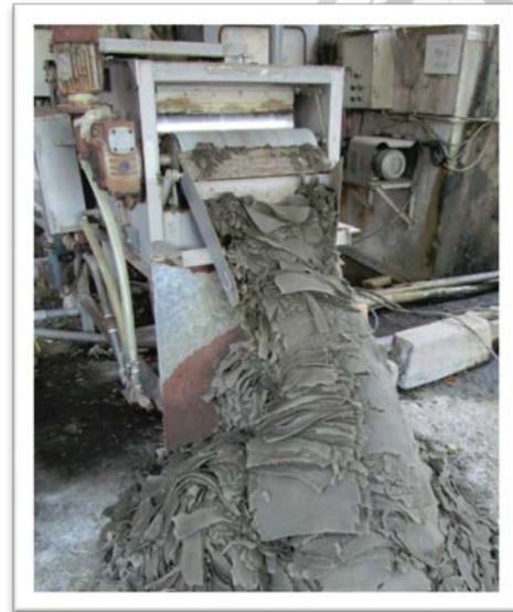
圖 4、污泥收集、迴流管及帶壓式脫水機 (於臺灣大學畜牧場)
