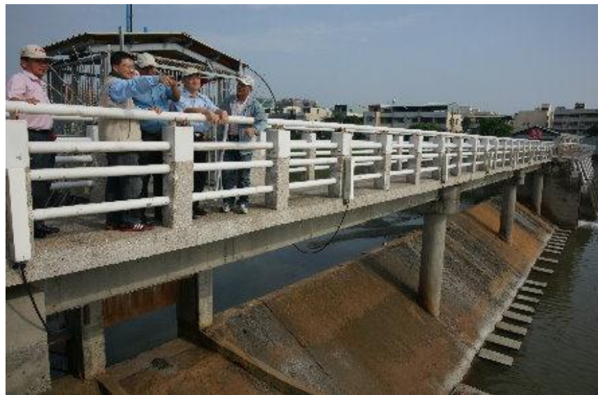
圖 3.1.12 後勁溪制水閘門
