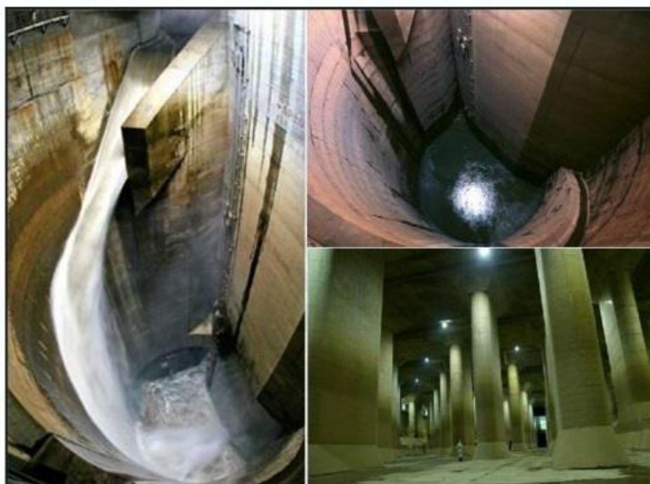
圖 1-4 日本東京地區外圍埼玉縣地下所設置地下滯洪排水系統(巨廷, 2013)
