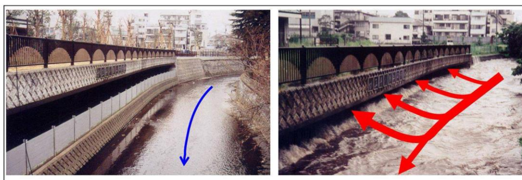
圖 1-5 神田川水系廟正寺川調節池(平時：左圖；洪水時期：右圖)
