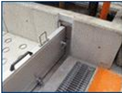
圖 1-11 住家入口處設置擋水板(臺北市信義區公所)
