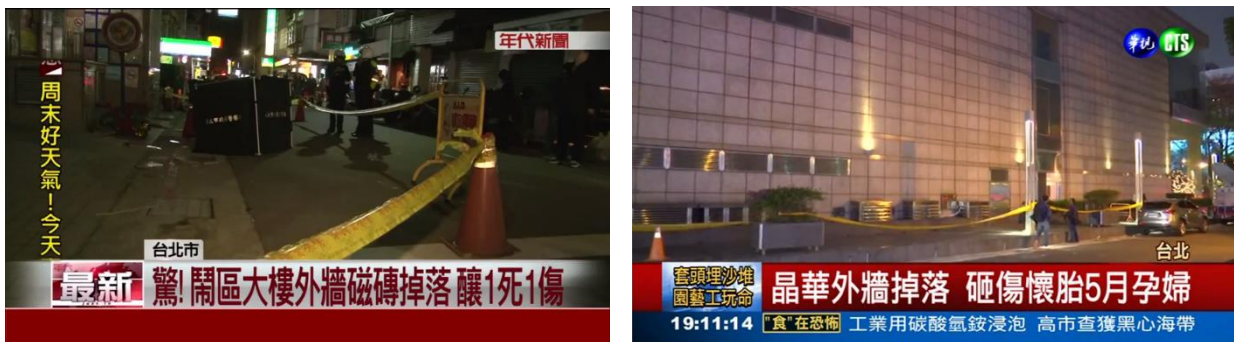
圖 1.1 聯合報大樓外牆磁磚剝落及晶華酒店外牆磁磚剝落
