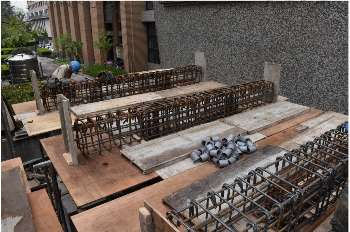
圖 3-19 施力梁鋼筋綁紮
