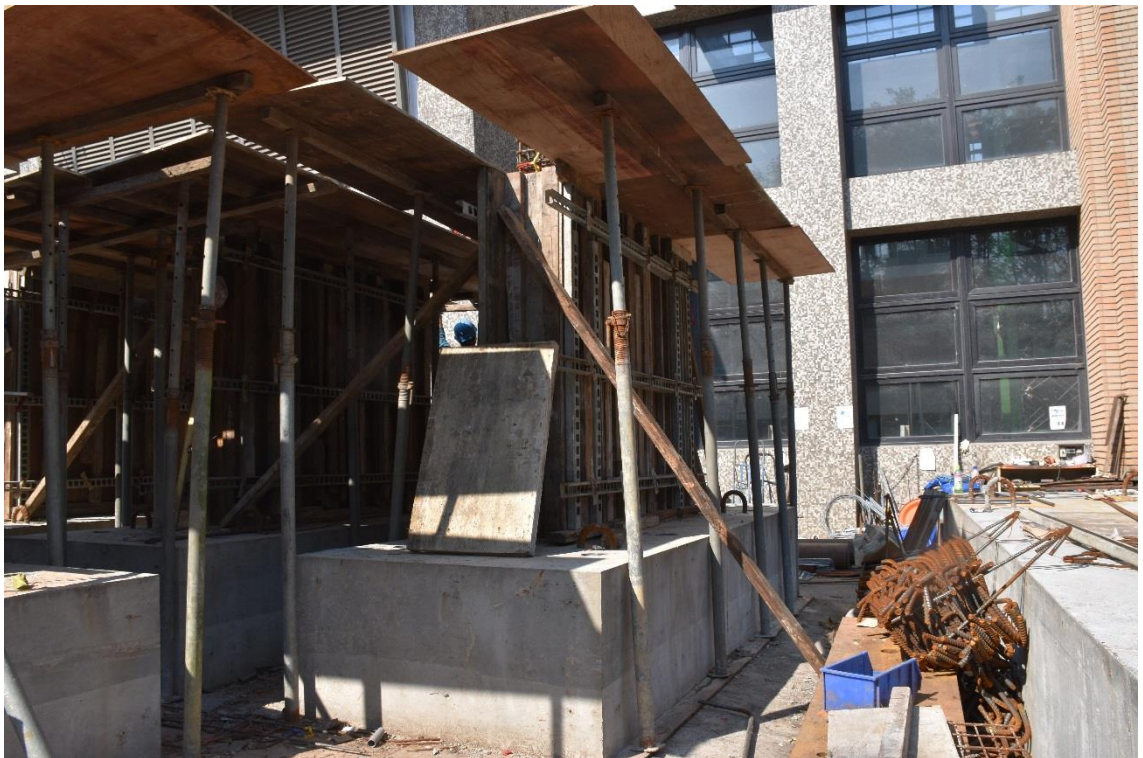
圖 3-18 牆體模板組立
