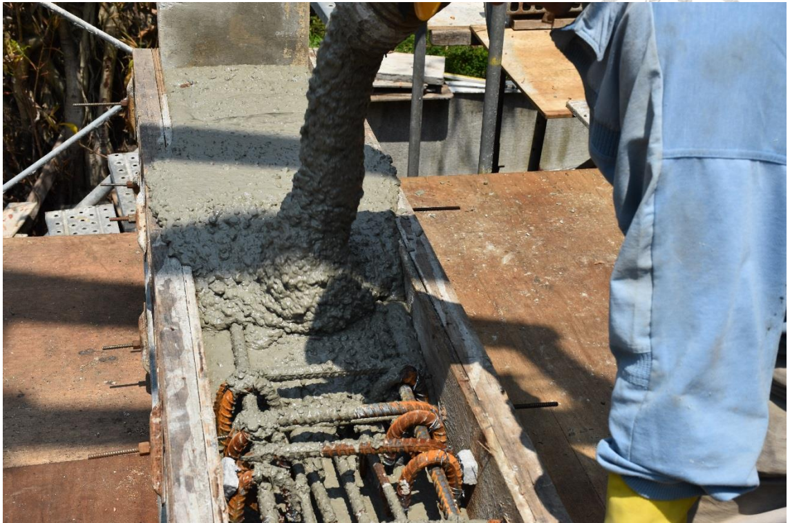
圖 3-21 上部結構混凝土澆置
