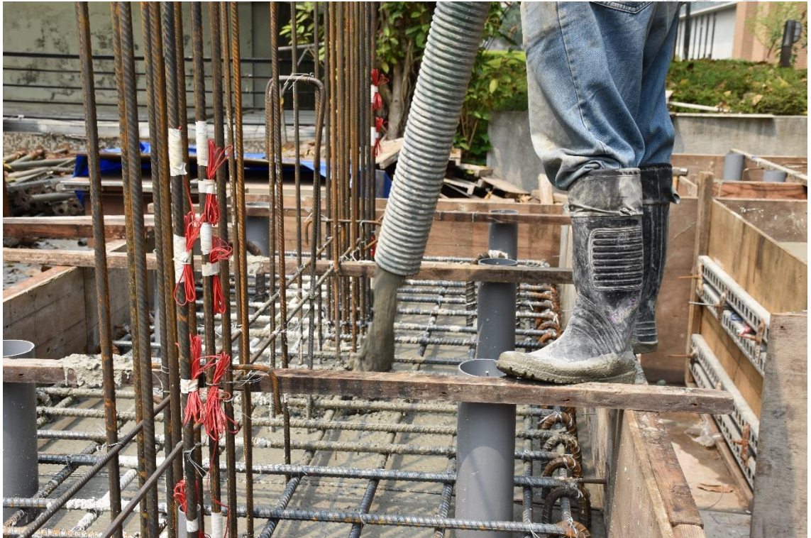
圖 3-17 基礎混凝土澆置
