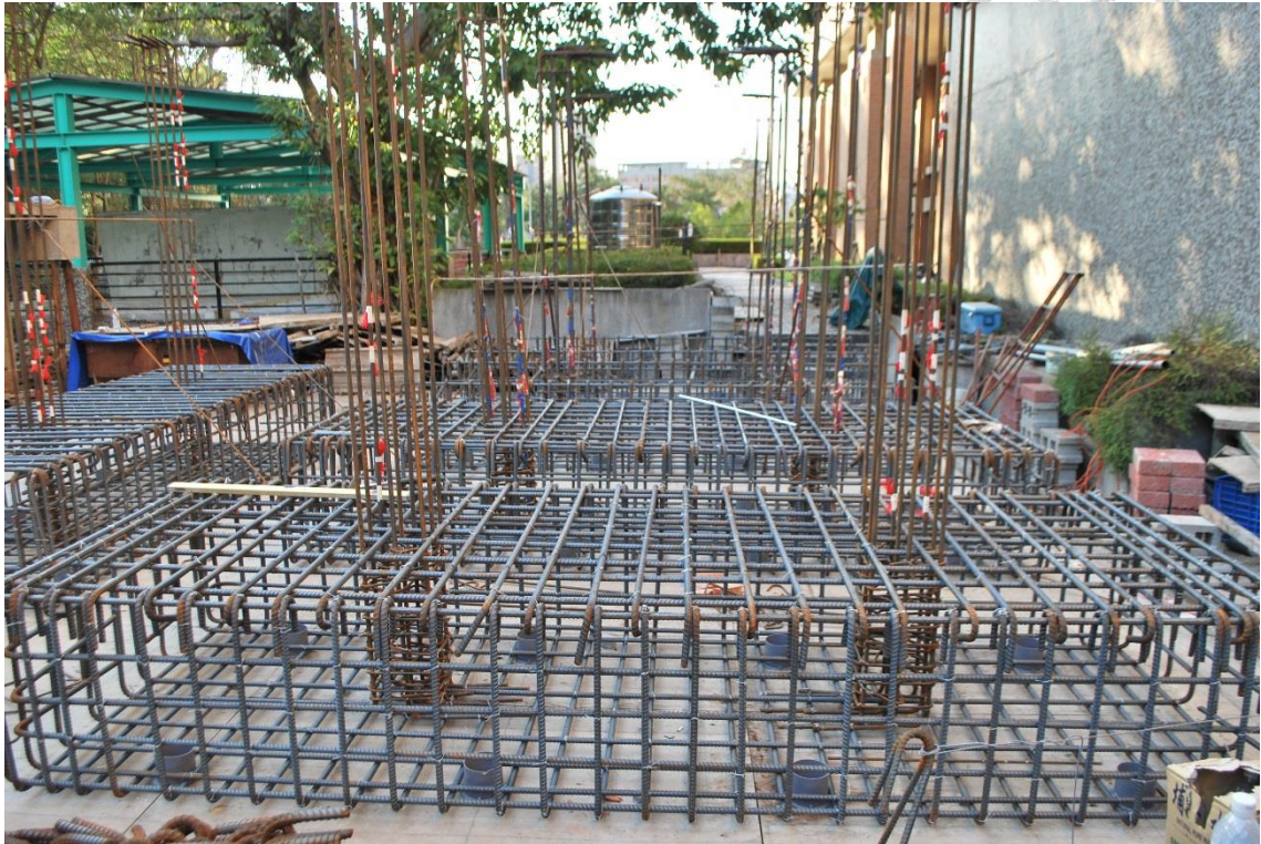
圖 3-15 基礎鋼筋與邊界構材主筋綁紮
