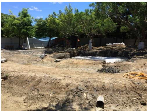
g、二期施工
